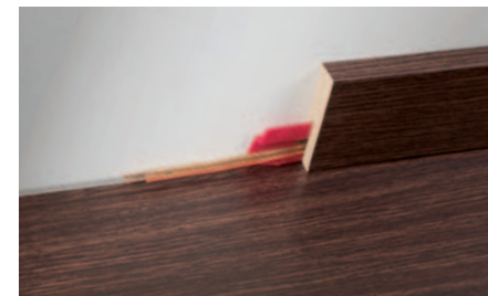
Červené přichytky lišt pro SL 4, SL 17 a SL 18 s 5 mm hloubkou vedení kabelů pro zakrytou instalaci kabelů od telefonu nebo reproduktorů.
