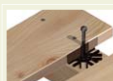
další terasové prkno zalícovat a přiložit
