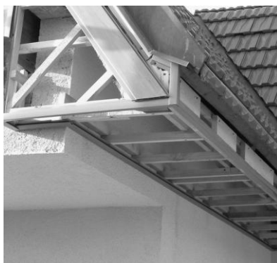
osazené ukončovací profily a první lamela
