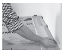
2. Vystředění/zaúhlování plochy pokládky a přizpůsobení první řady lamel seřiznutím.
