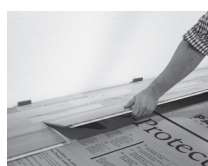
5. Další řada znovu začíná zleva. Jednoduše do sebe lamely po délce zavakněte. Lepení lamel není potřebné.
