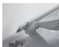
8. Kraje spáry se zakryjí vhodnými podlahovými lištami z bohatého sortimentu Parador.
