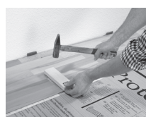
6. Čelní spáry sklepněte k sobě pomocí paličky. Podélné a čelní spáry se přitom automaticky uzavřou. S touto pokládkou pokračujte v celé místnosti.
