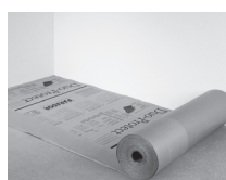
1. Pokládka podložky na připravený podklad.
