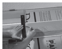
4. Poslední lamela první řady se zkrátí na potřebnou délku tak, aby byla dodržena vzdálenost ke zdi. Odříznutý kus lamely se použije jako začátek druhé řady.
