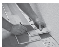
7. Pomocí zbylého kusu se průběh stěny přenese na poslední řadu lamel.
